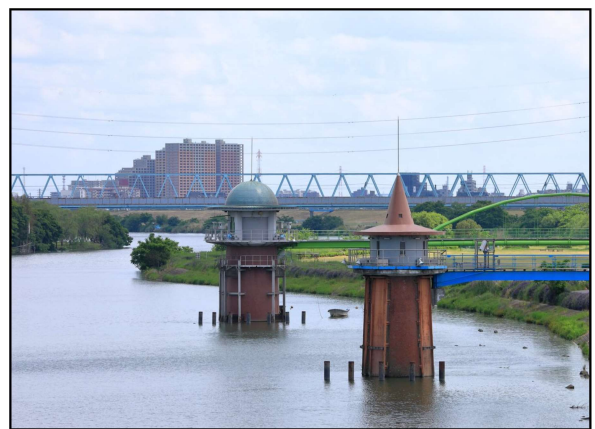
左：第3取水塔 右：第2取水塔
