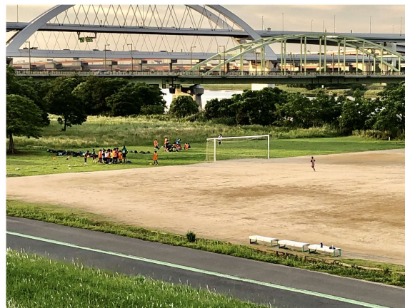
緊急用河川敷道路とサッカー場
