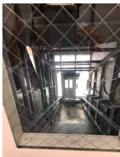
斜めのレールが外からも良く見える 甲府駅の斜行エレベーター
